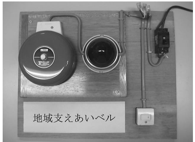
家屋の外壁等にベル本体を設置し、屋内にはスイッチを2か所設置します。
